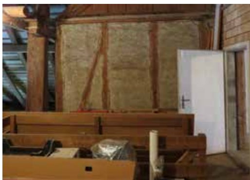
Abb. 134 Statthaltersaal (Foto Kulturdetektive 2015)
