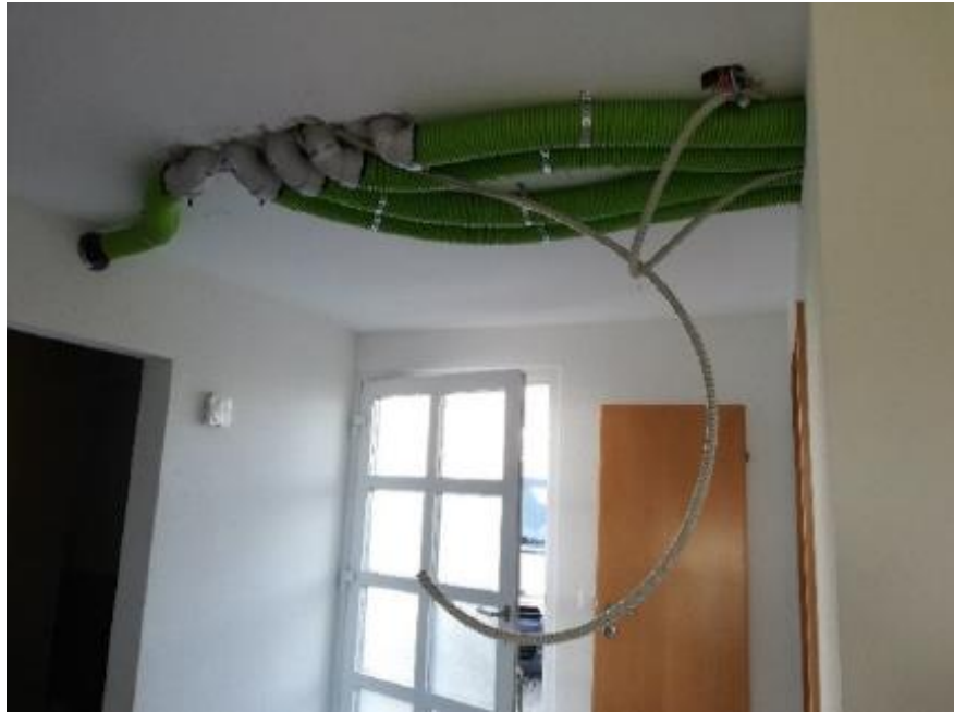
während Lüftungsinstallation
