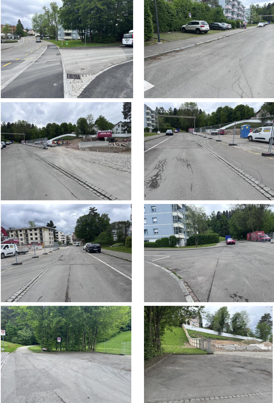
Abbildung 15: Fotos Projektperimeter (Quelle: INSTRAG Bauingenieure AG)
