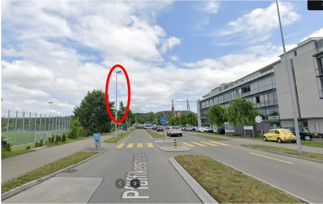
Abbildung 35: Kandelaber für die Kamera in FR Uster bei der Messstelle 8, Pfäffikerstrasse in Uster
