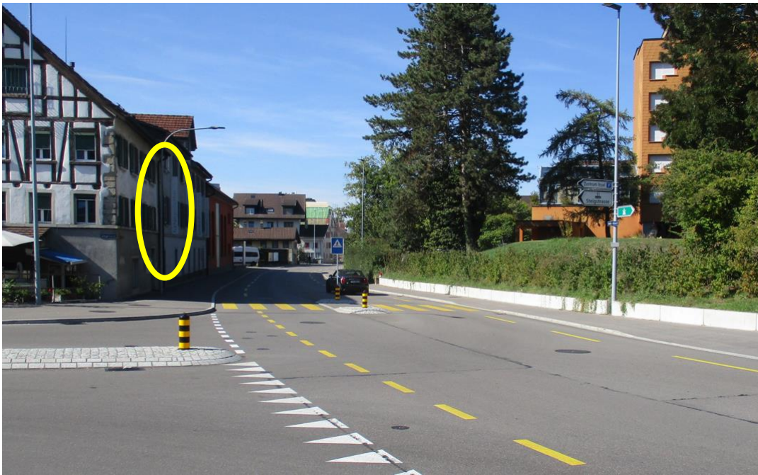
Abbildung 32: Kandelaber für die Kamera in FR Autobahn bei der Messstelle 7, Aathalstrasse in Uster
