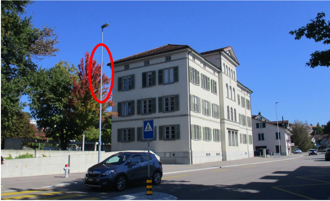
Abbildung 31: Kandelaber für die Kamera in FR Uster bei der Messstelle 7, Aathalstrasse in Uster
