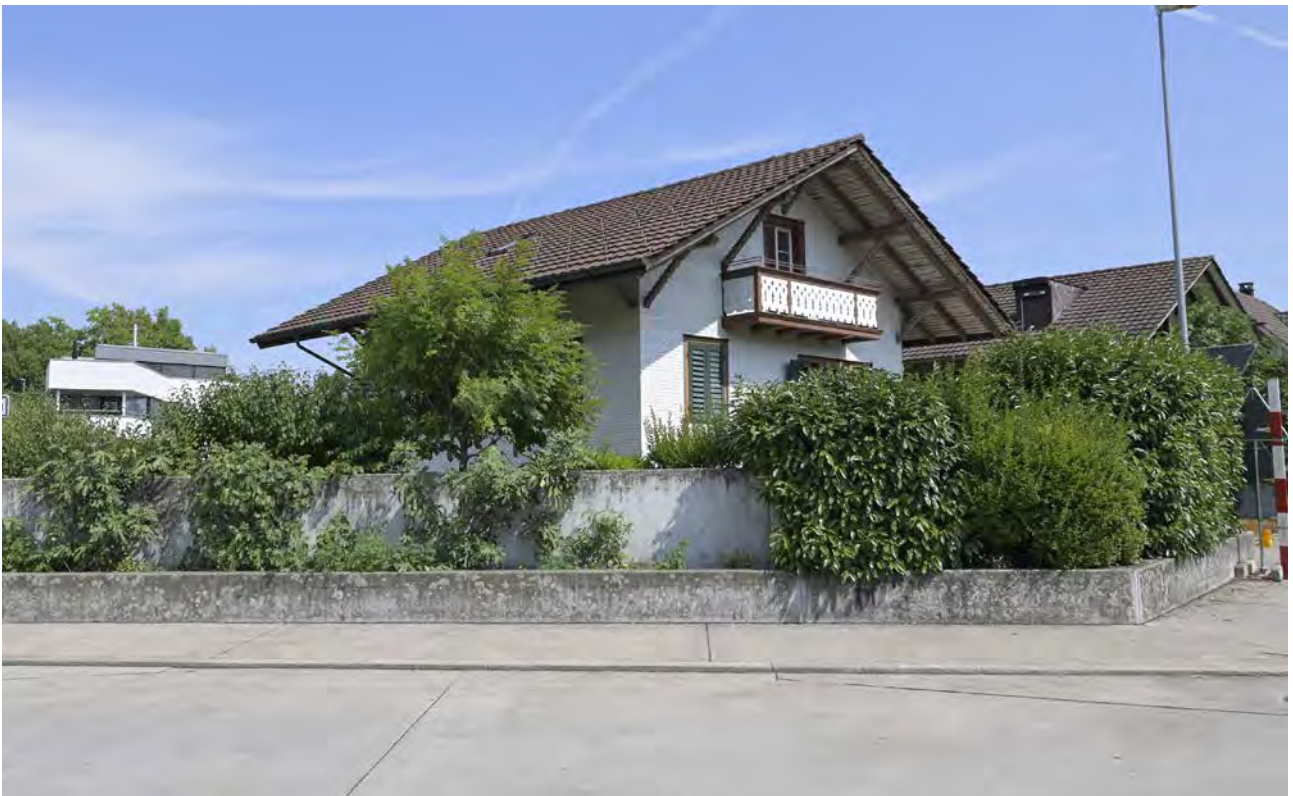
Seestrasse 46, Ansicht von Südwesten [vestigia 17.08.2022]
