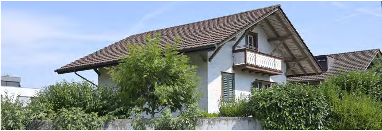
Seestrasse 46, Ansicht von Südwesten [vestigia 17.08.2022]
