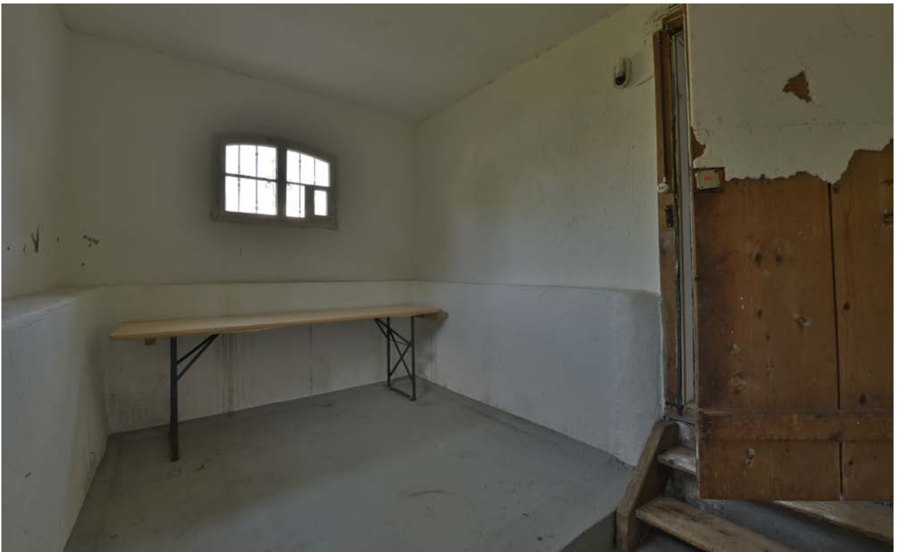
Seestrasse 46, Ansicht des Untergeschosses [vestigia 17.08.2022]
