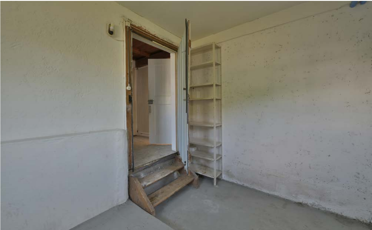
Seestrasse 46, Ansicht des Untergeschosses [vestigia 17.08.2022]
