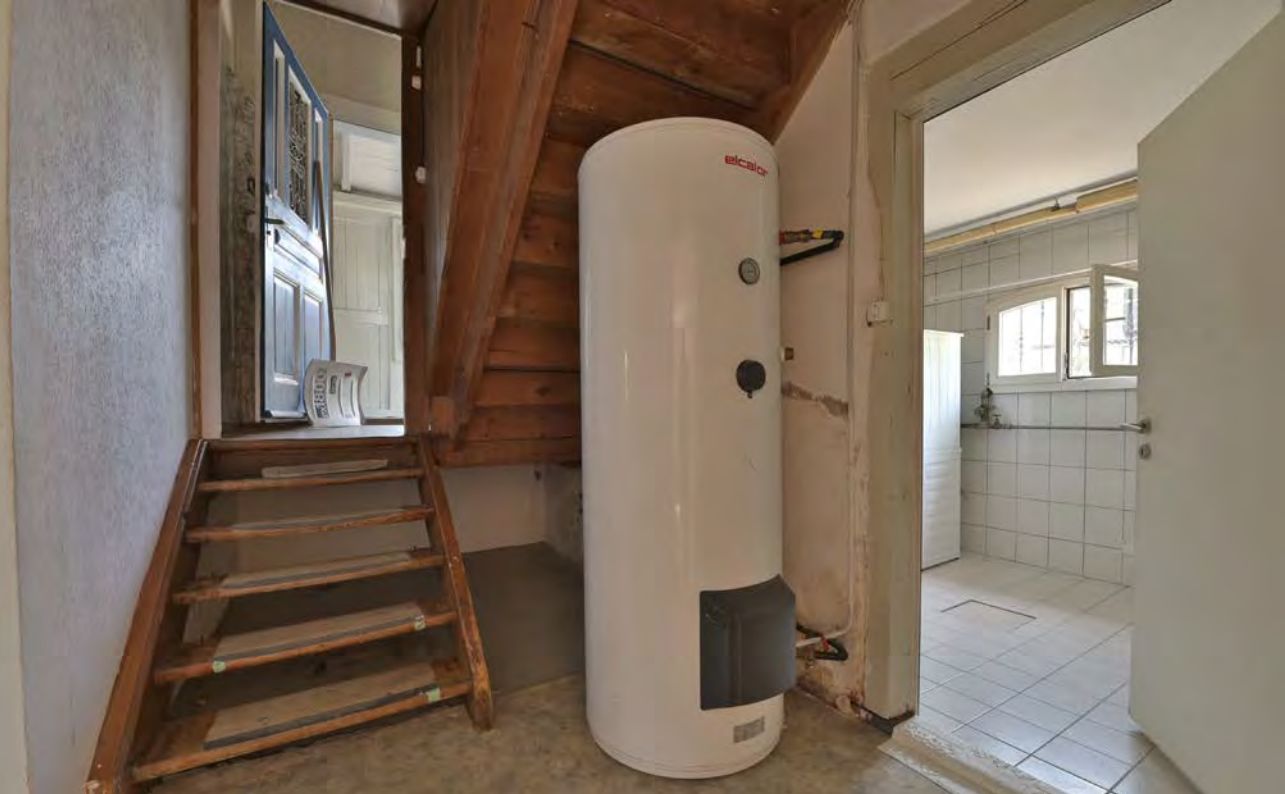
Seestrasse 46, Ansicht des Untergeschosses [vestigia 17.08.2022]
