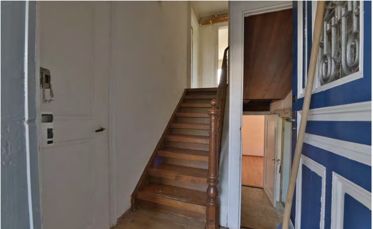
Friedhofallee 2, Ansicht des Eingangsbereichs in das erste Obergeschoss sowie ins Untergeschoss [vestigia 10.05.2022]
