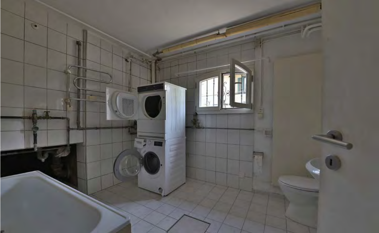
Seestrasse 46, Ansicht des Untergeschosses [vestigia 17.08.2022]
