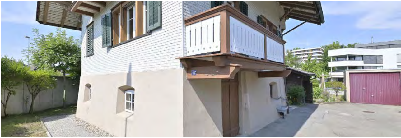
Seestrasse 46, Ansicht eines Fassadendetails [vestigia 17.08.2022]
