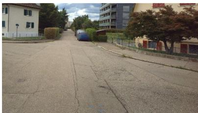
Unebenheiten, offene Nähte, Längsrisse und Belagsrandrisse, Flicke mit Folgeschäden
