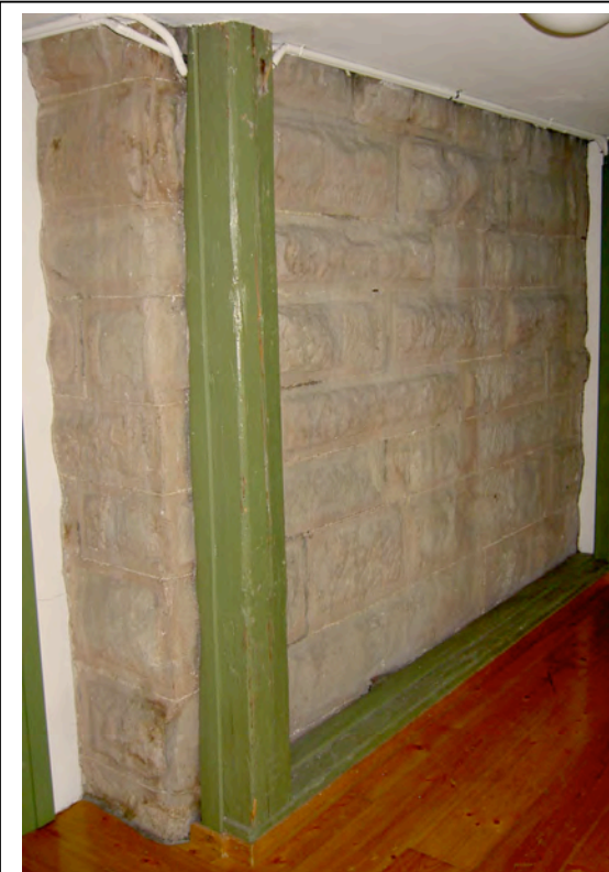
Die nordöstliche Ecke des mit Bossenquader mit Randschlag geschmückten Turmes ist im Innern der Schule gut sichtbar (Photo: Fabrice Burllet, 2012).
