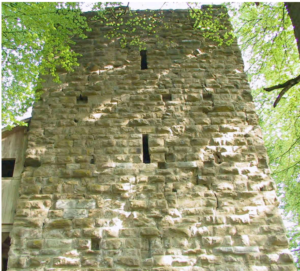
Auf der Burg Alt-Wülflingen in der Gegend von Winterthur liegt die Ruine eines Turmes, dessen Fassaden – wie in Uster – aus Bossenquadern mit Randschlag besteht (Photo: Fabrice Burlet, 2011).
