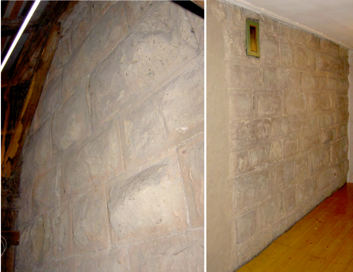
Bossenquader mit Randschlag an der Fassade des Burgturms von Uster. Die Turmfassaden sind heute im Innern der Schule zu bestaunen (Photo: Fabrice Burlet, 2012).
