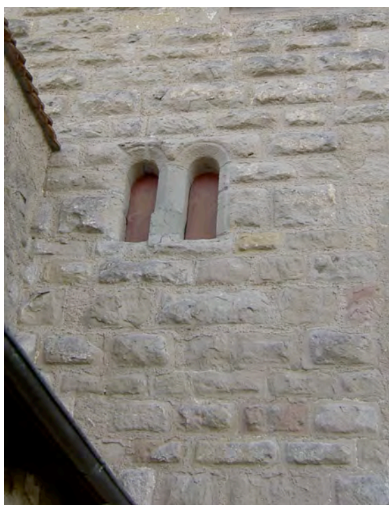
Auf der Kyburg findet man romanische Doppelfenster im Bossenquadermauerwerk des Wohngebäude integriert (Photos: Fabrice Burlet, 2012).
